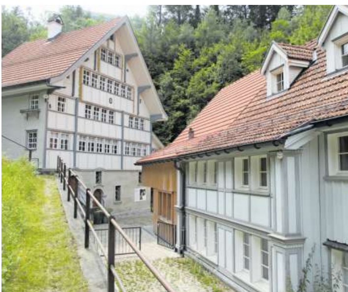
Das Müllereigebäude am Gstaldenbach (Wolfhalden/Heiden) wird mit Wasserrad und Mühlenraum aufgewertet. Das Nebengebäude dient dem Atelier «Einklang» und den Vorderländer Pfadfindern. Bild: PE
